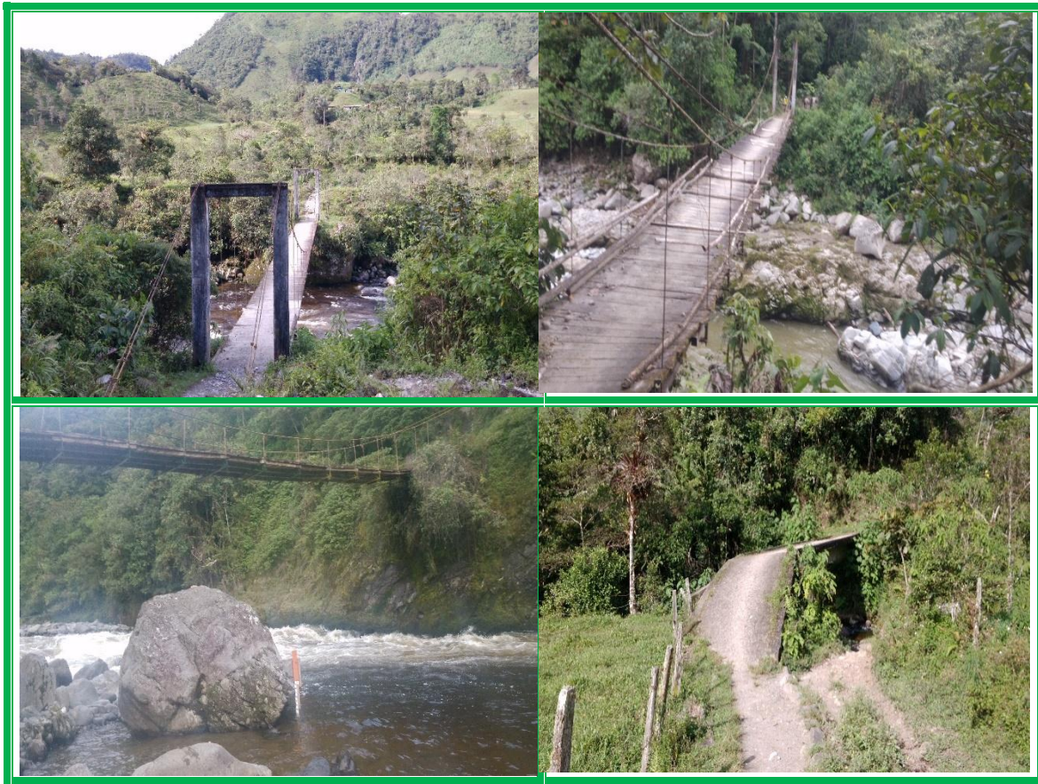
Fotografía 11. Puentes De Conectividad Municipio De Santa Rosa Cauca
