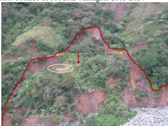
Foto No. 1: Derrumbe P.R. 41+023 vía Palmitas - Almaguer
